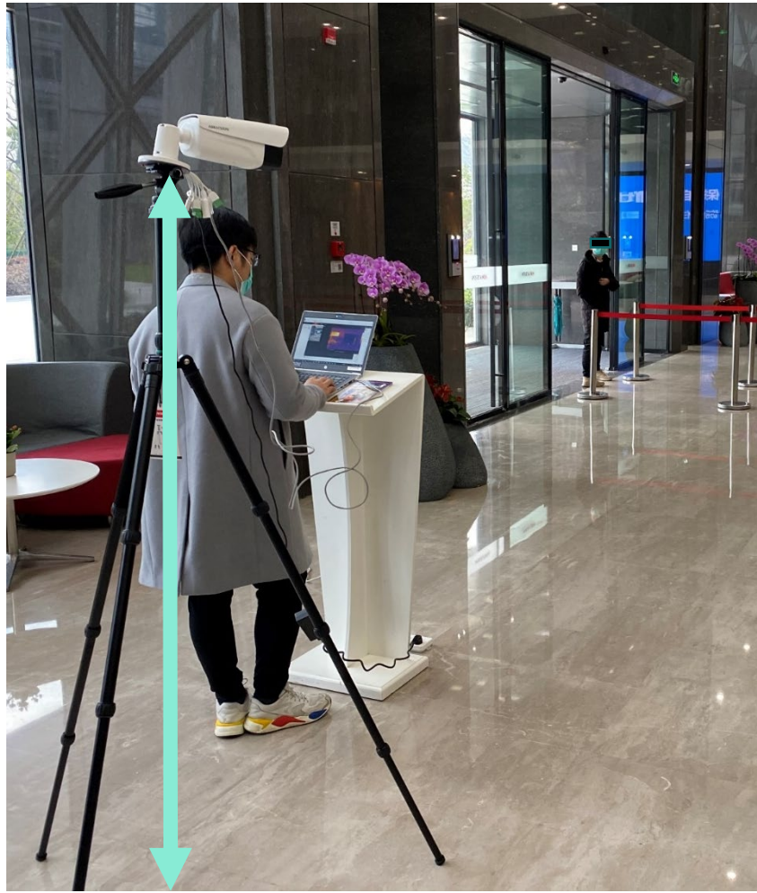
Tijdelijke installatie op statief
